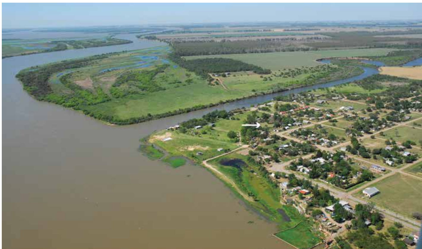
Figura 2. Fotografía aérea del actual puerto Gaboto, situado a unos 50km al norte de Rosario, sobre el río Coronda (abajo y a la izquierda), en el lugar en que este recibe las aguas del Carcarañá (cauce angosto que llega desde la derecha). Hacia el fondo de la imagen, que fue tomada mirando aproximadamente al sur y a unos 7km aguas abajo de la confluencia, el Coronda desemboca en el Paraná.
